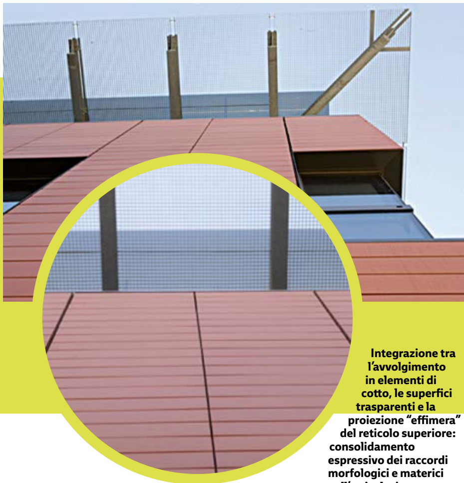
Nicholas Grimshaw and Partners, University College London's New Engineering Building, Londra. Armonia e suggestioni archetipiche dei materiali tradizionali in facciata: tessitura perimetrale in profili di alluminio a supporto dei moduli e delle fasce in laterizio e in vetrocamera
