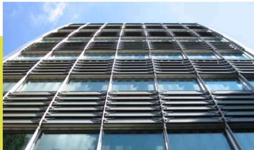
Nicholas Grimshaw and Partners, Gresham Street Office Building, Londra. Impiego delle chiusure trasparenti, osmotiche, dotate di componenti "ibridati" e atualizzati rispetto alla tradizione costruttiva, all'interno di un reticolo modulare: adozione di componenti e di pezzi per le facciate in grado di radunare gli stilemi archetipici della cultura materiale e i canoni dell'innovazione tecnico-produttiva
