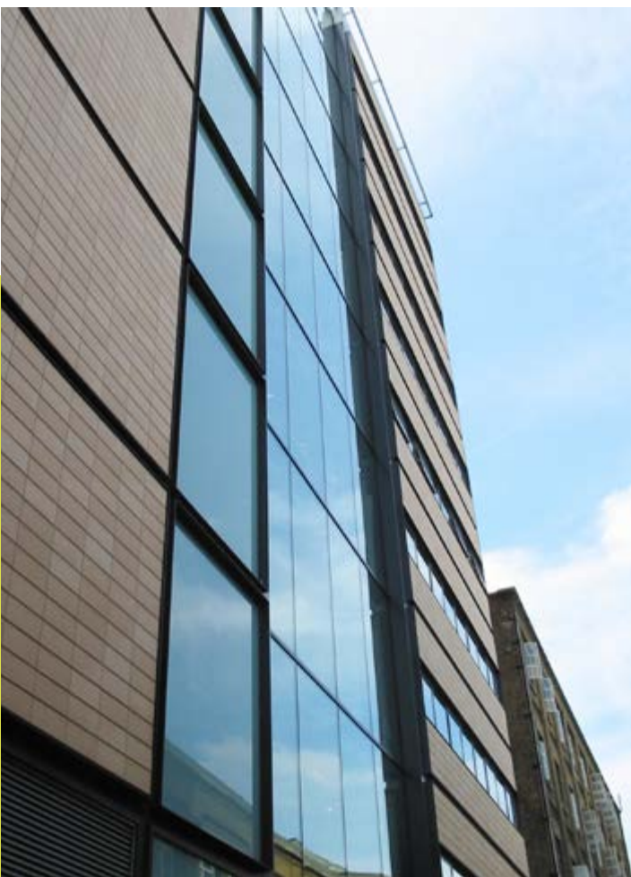
Nicholas Grimshaw and Partners, University College London's New Engineering Building, Londra. Armonia e suggestioni archetipiche dei materiali tradizionali in facciata: tessitura perimetrale in profili di alluminio a supporto dei moduli e delle fasce in laterizio e in vetrocamera
