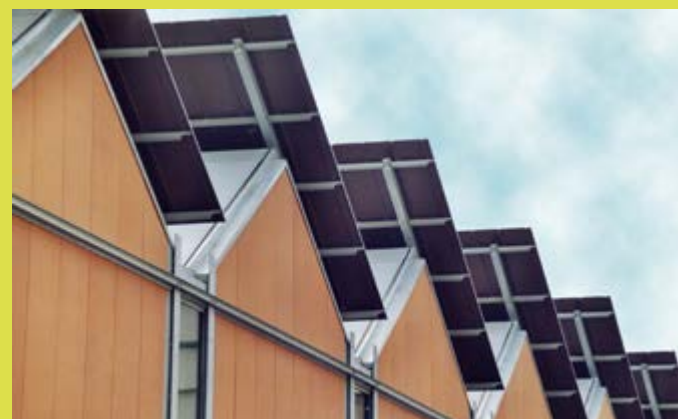
Renzo Piano Building Workshop, sede EMI Records, Parigi. Chiusure di involucro in pannelli di laterizio entro l'intelaiatura verticale, orizzontale e di copertura in acciaio zincato, enfatizzando il carattere "tettonico" e "massivo" delle cortine perimetrali nel contesto urbano
