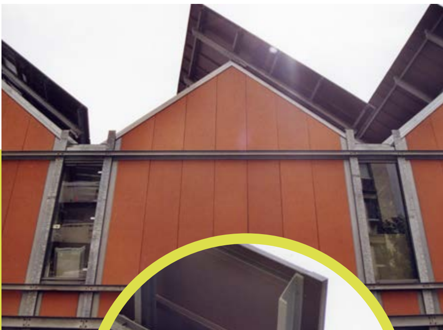
Renzo Piano Building Workshop, sede EMI Records, Parigi. Soluzione morfo-tipologica archetipica della successione di facciata, nel richiamo delle cuspidi a falde e delle connessioni a pressione mediante l'intelaiatura esterna
