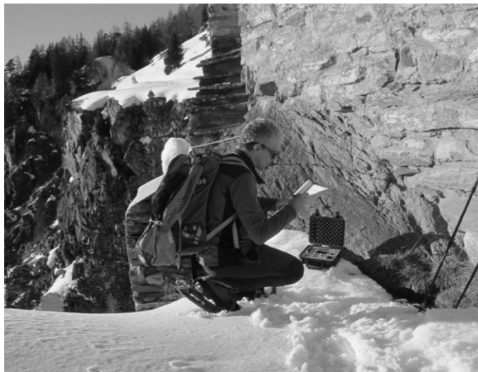
Fig. 4. Attività di monitoraggio strutturale durante la stagione invernale
