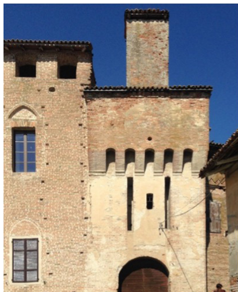
Fig. 5- La “torre di ingresso”, il “torrino con apparato a sporgere” e le tracce degli alloggiamenti per i bulzoni del ponte levatoio (foto di Michela Marisa Grisoni, 2020)
