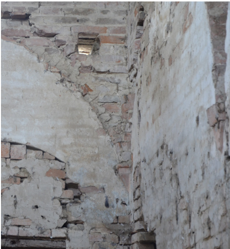
Fig. 9- Indizi intatti anche lungo i ‘bordi’ permettono di ‘immaginare’ le volte crollate (foto di Michela Marisa Grisoni, 2018)
