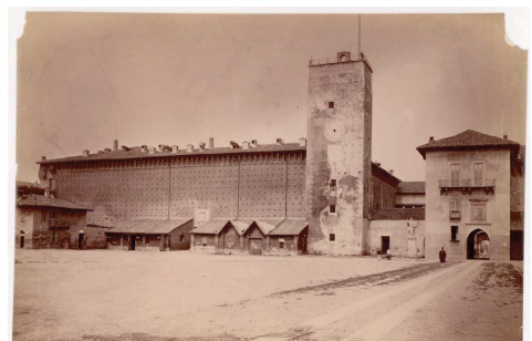
Fig. 7- Giulio Rossi (attr.), Accesso alla corte ducale - Torre di Bona e Rocchetta prima del restauro, post 1878 - ante 1884 (Civico Archivio Fotografico di Milano, Raccolta Luca Beltrami, RLB 2688)
