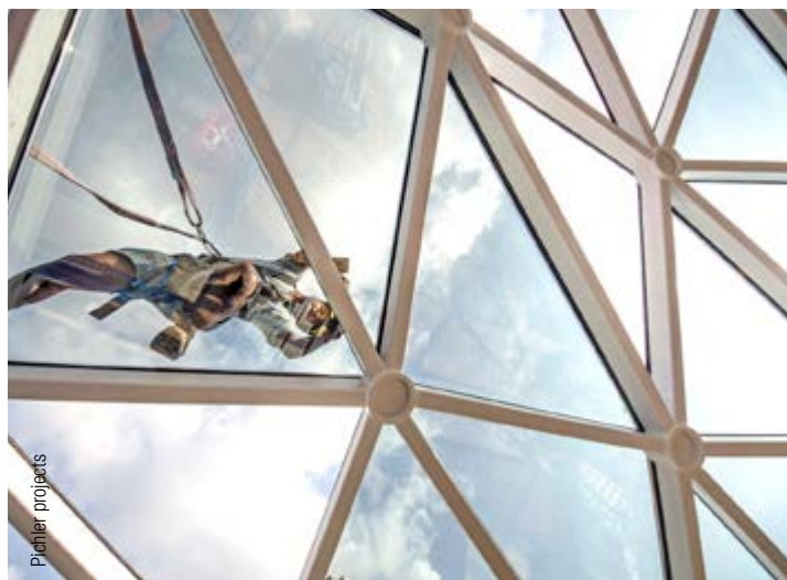
Interfaccia di connessione tra aste profilari mediante i nodi a "stella" composti da piastre in acciaio a scomparsa e saldate internamente ai profili tubolari
