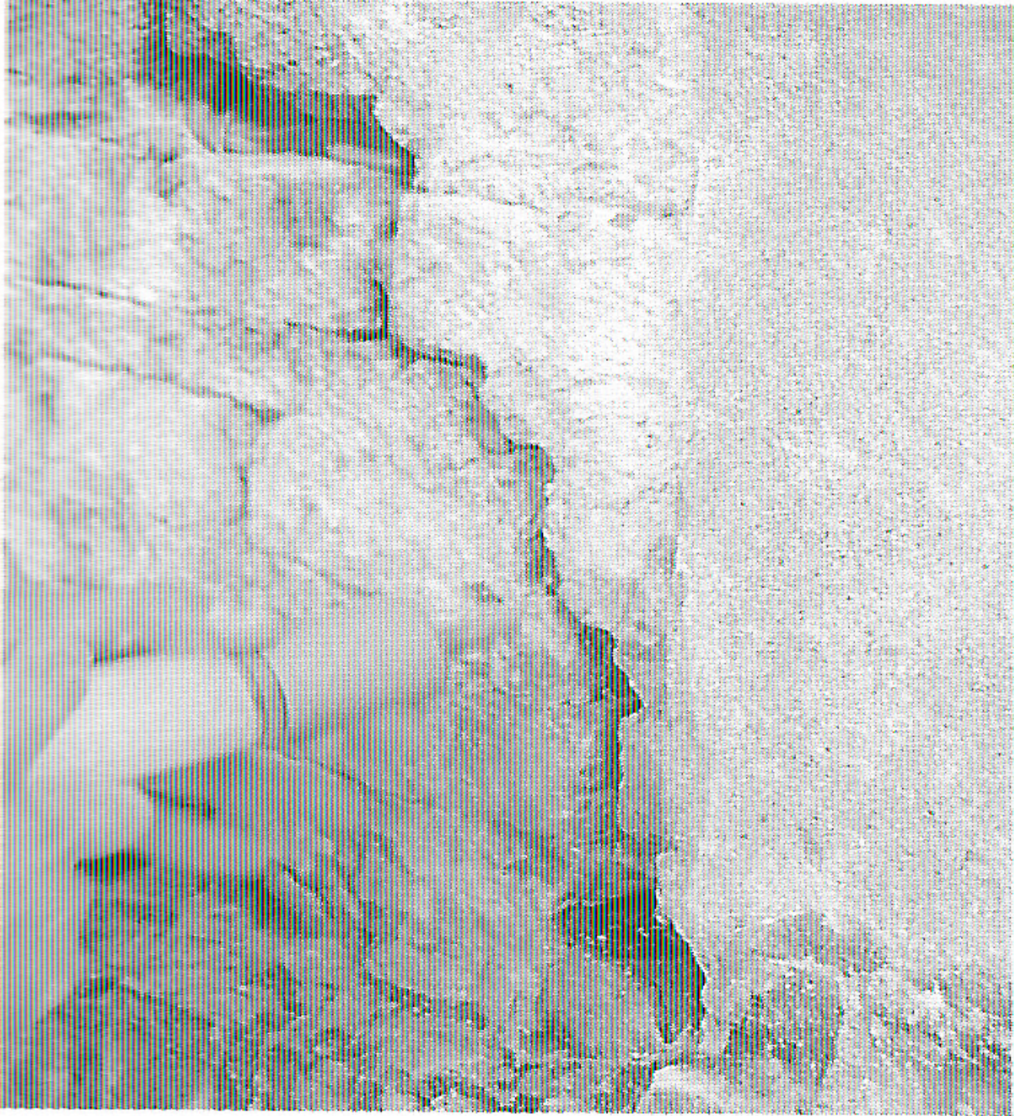
6. Interventi per il blocco dell'umidità da risalita.
