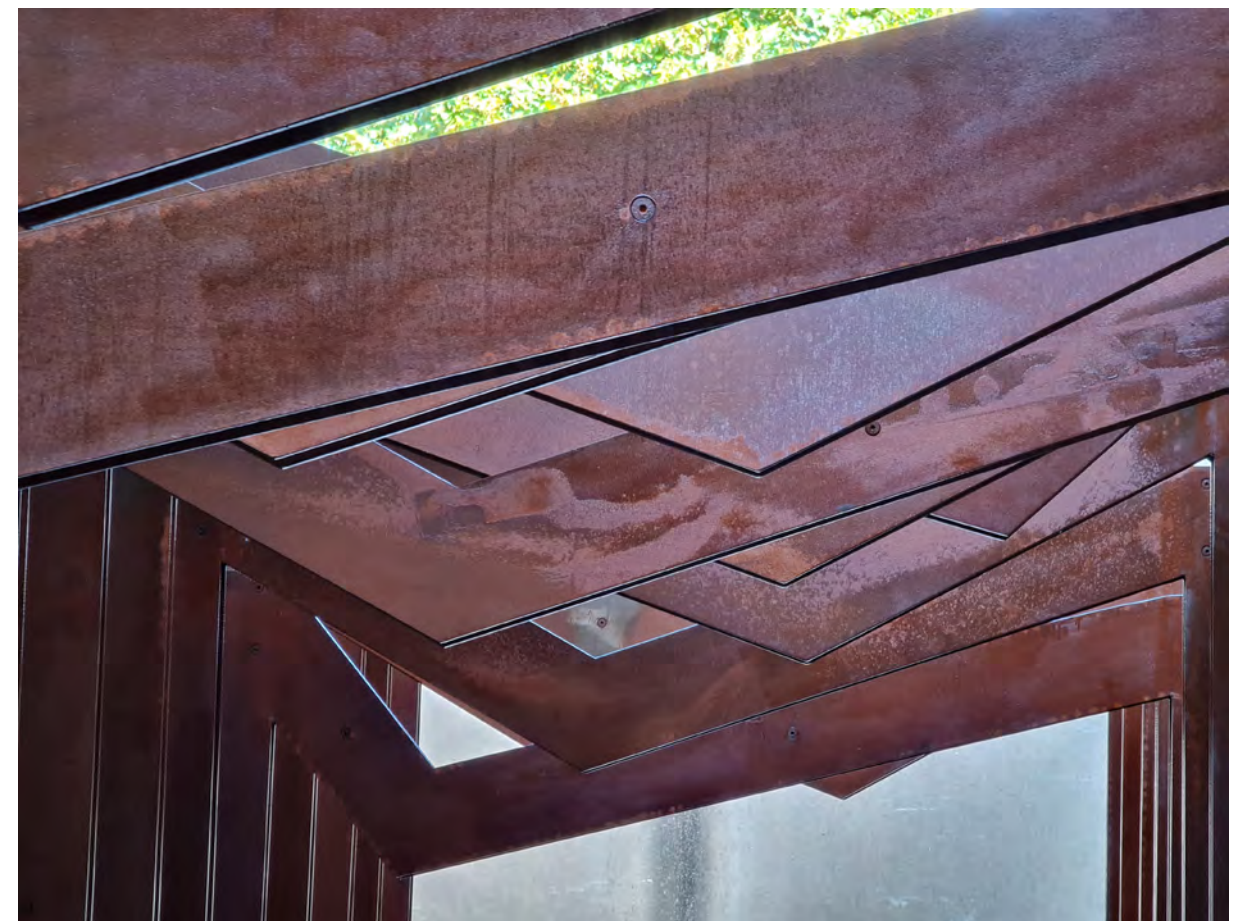
Fig. 34 - Particolare portali in ferro ossidato.
