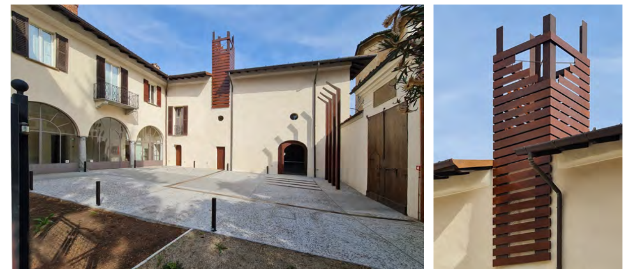
Fig. 9-10 - A destra, la corte interna con le nuove pavimentazioni in pietra sinterizzata e calcestruzzo architettonico. A sinistra, nella pavimentazione ritroviamo l'antico sedime di Santa Marta segnato da una lamiera in ferro ossidato. Il nuovo campanile, un "non finito" a segnare memoria e atemporalità.
