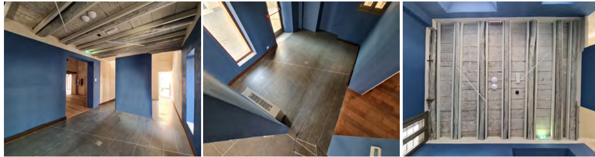
Fig. 11-12-13 - Il soffitto del locale di ingresso conservato e consolidato all'intradosso inserendo tubolari rettangolari in acciaio accoppiati alle travi esistenti. Sopra, i nuovi pavimenti in seminato cementizio.
