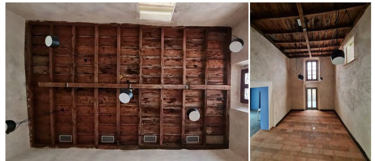
Fig. 21-22 - Il locale della ex sacrestia. Il soffitto ligneo è stato integralmente conservato, così pure buona parte degli intonaci in malta di calce idraulica. La pavimentazione in cotto, ormai priva di sottofondo e scarsamente allettata è stata rimossa e ricollocata una volta realizzato il vespaio areato.
