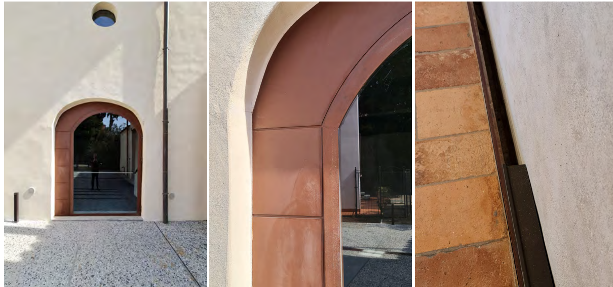
Fig. 26-27-28 - I nuovi serramenti in ferro ossidato e passivato, materiale che ricorre, definisce e segna i nuovi inserimenti architettonici: i portali del vicolo, il campanile, la pensilina del cortiletto, il sedime a terra della chiesa perduta, i montanti della corte, gli zoccolini interni.
