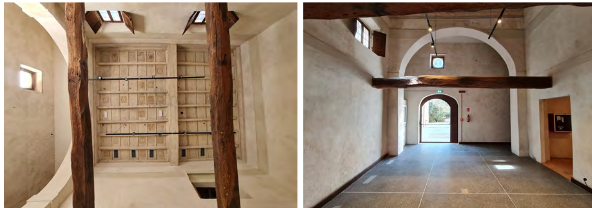
Fig. 14-15 - La Sala San Martini. È la parte residua dell'antica Santa Marta liberata dalla tamponatura dell'arco trionfale (realizzata in legno) e del solaio del quale si sono voluti conservare i principali elementi strutturali e la traccia muraria perimetrale.
