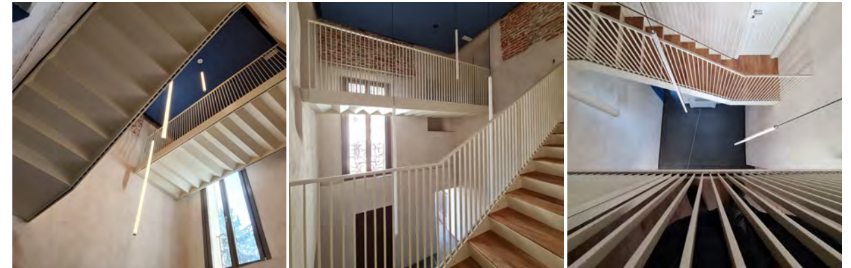
Fig. 18-19-20 - Nuova scala di collegamento tra piano intermedio e primo; nuova passerella tra vano ascensore e piano primo. (realizzata in legno) e del solaio del quale si sono voluti conservare i principali elementi strutturali e la traccia muraria perimetrale.
