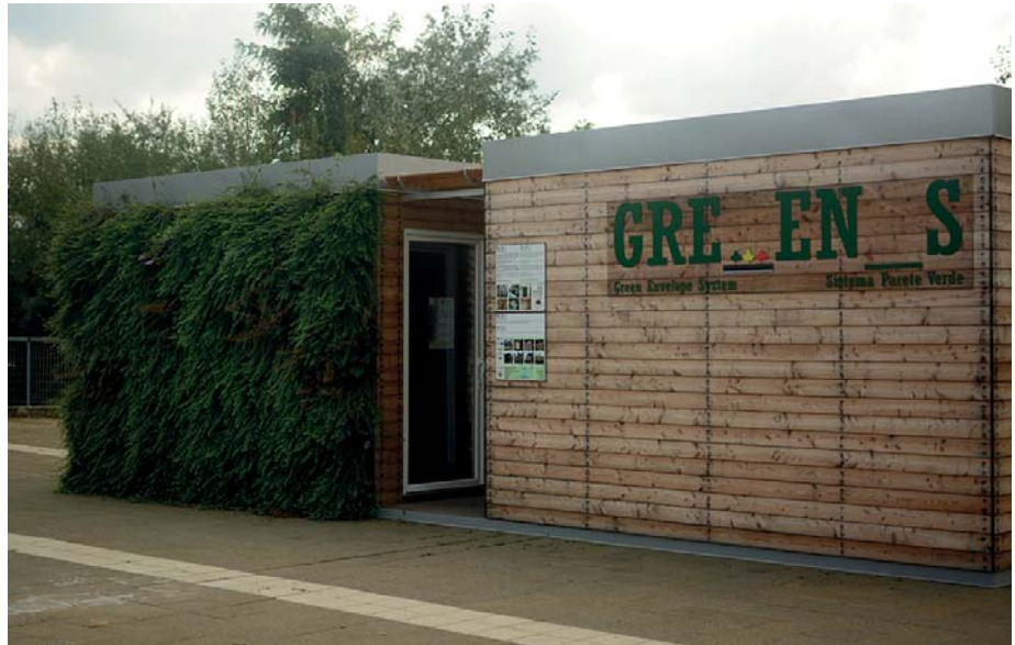
Figura 2.4.12 Edificio campione realizzato a Environment Park (TO) per i monitoraggi in situ.
