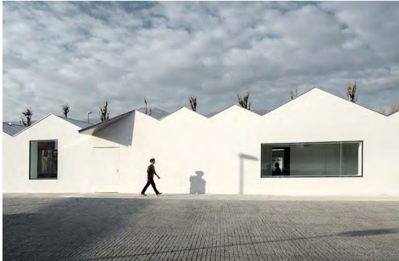
Vista del Centro socio-educativo. Risaltano la copertura a falde irregolari senza gronde e il montaggio a filo esterno degli infissi.
