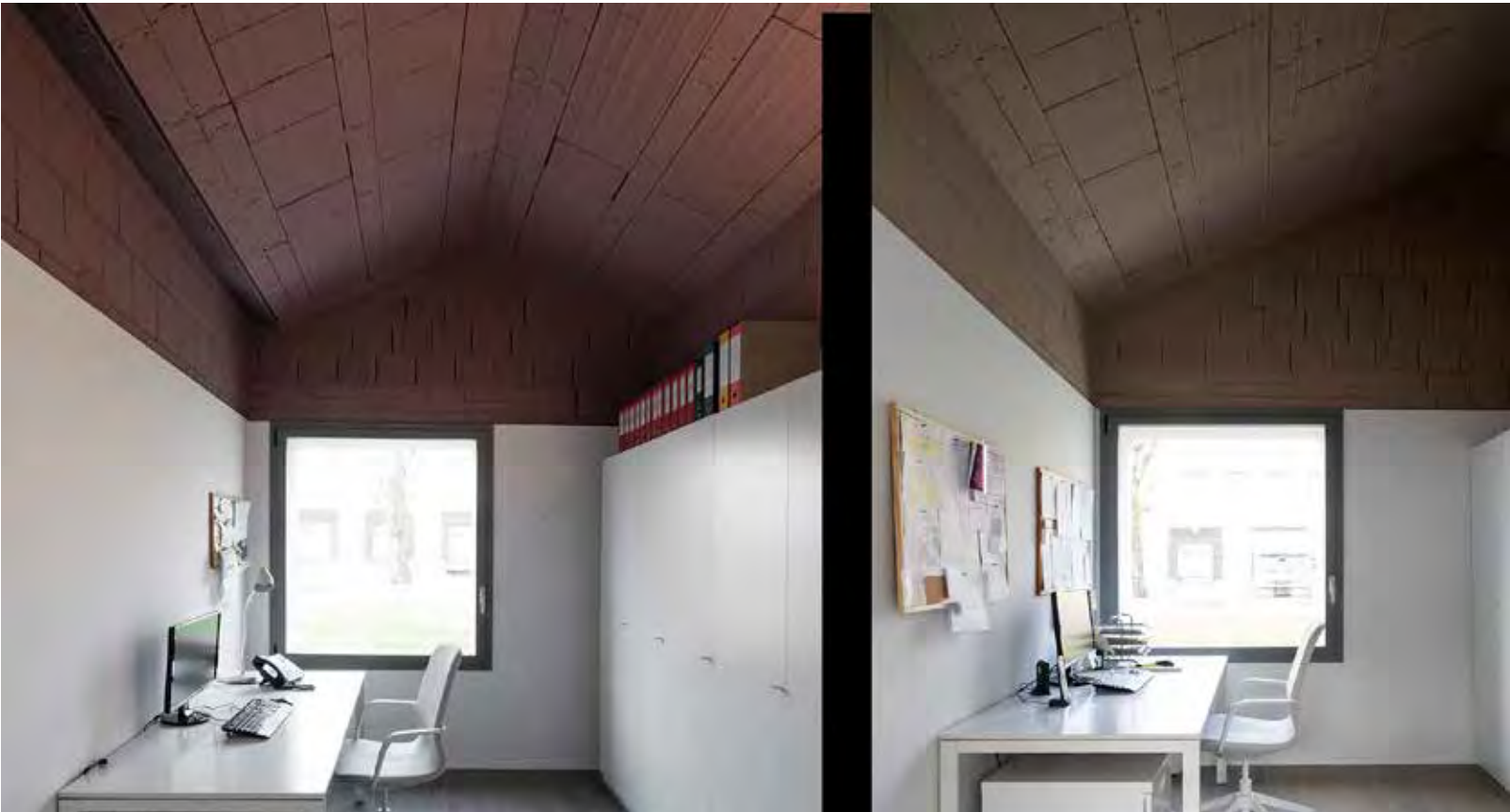
Uffici: variazione cromatica dell'intradosso con travetti e laterizi a vista
