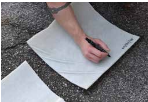
Prelievo di campioni - cantiere BrianzAcque srl
