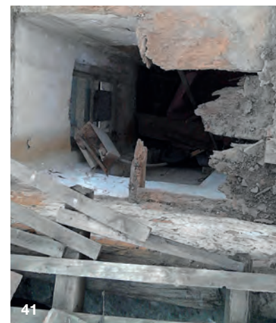
Fig. 37-41. I manti di copertura, rotti e sconnessi in svariati punti, hanno di fatto causato l'evidente degrado riscontrato a livello delle orditure lignee primarie e secondarie. Risultavano inoltre non più efficienti, quando non mancanti, gli impianti di raccolta e allontanamento delle acque piovane (canali, pluviali, scossaline, pozzetti) (foto: Donatello SpA)
