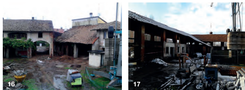
Fig. 15-17. Il cantiere in allestimento (foto: Donatello SpA)
