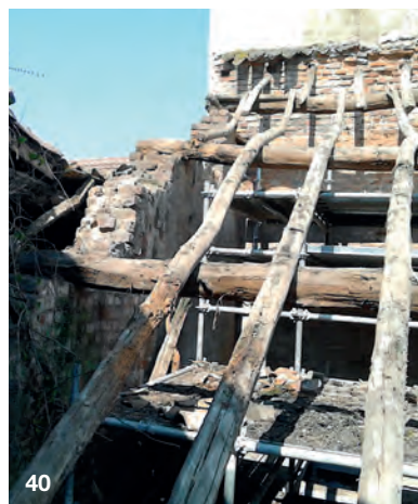
Fig. 37-41. I manti di copertura, rotti e sconnessi in svariati punti, hanno di fatto causato l'evidente degrado riscontrato a livello delle orditure lignee primarie e secondarie. Risultavano inoltre non più efficienti, quando non mancanti, gli impianti di raccolta e allontanamento delle acque piovane (canali, pluviali, scossaline, pozzetti) (foto: Donatello SpA)
