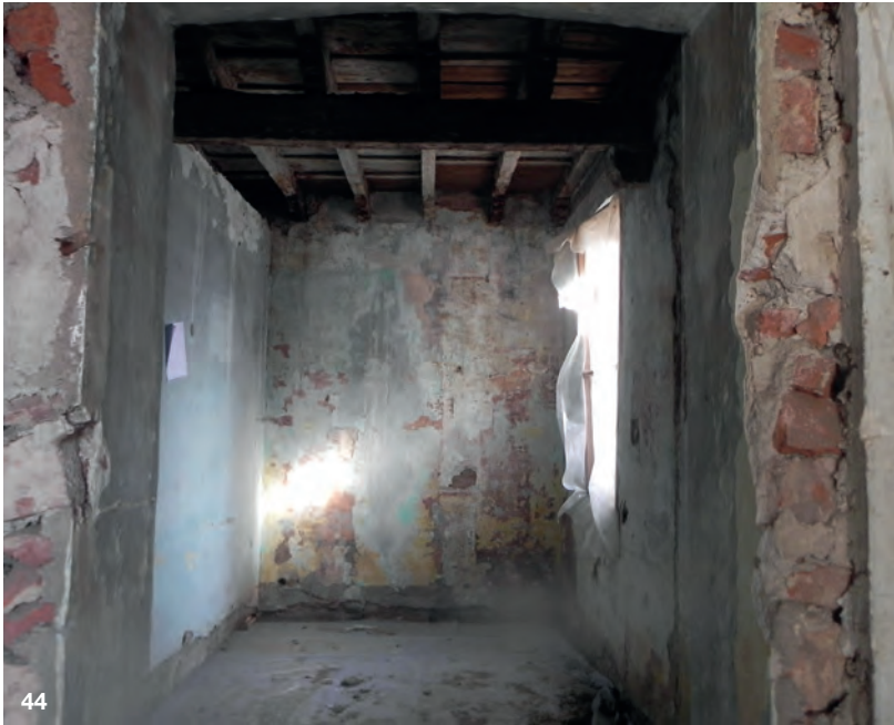
Fig. 42-45. Intonaci esterni e interni soffrono di evidenti problematiche causate dalle infiltrazioni meteoriche, dall'umidità ascendente e discendente (foto: Donatello SpA)
