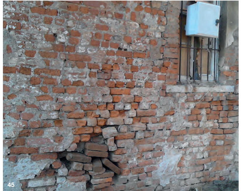
Fig. 42-45. Intonaci esterni e interni soffrono di evidenti problematiche causate dalle infiltrazioni meteoriche, dall'umidità ascendente e discendente (foto: Donatello SpA)
