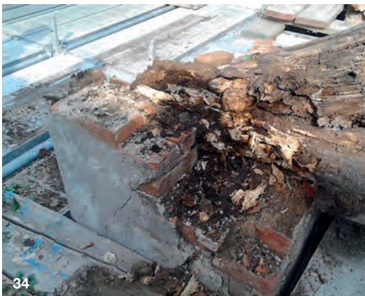
Fig. 28-36. Gran parte delle coperture denunciavano pesanti problematiche, in special modo nei riguardi delle orditure lignee primarie e secondarie quali mancanza, rotture, marcescenze diffuse o disconnessioni (foto: Donatello SpA)
