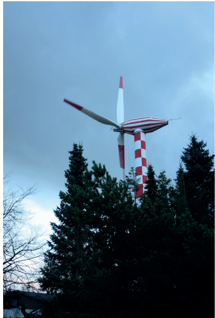
Tvindkraft (Fig. 1), una turbina eolica che è stata costruita e installata nel 1978 da centinaia di persone della comunità danese di Ulfborg, rappresenta una delle sue prime espressioni. Da allora, le comunità energetiche sono cresciute soprattutto
