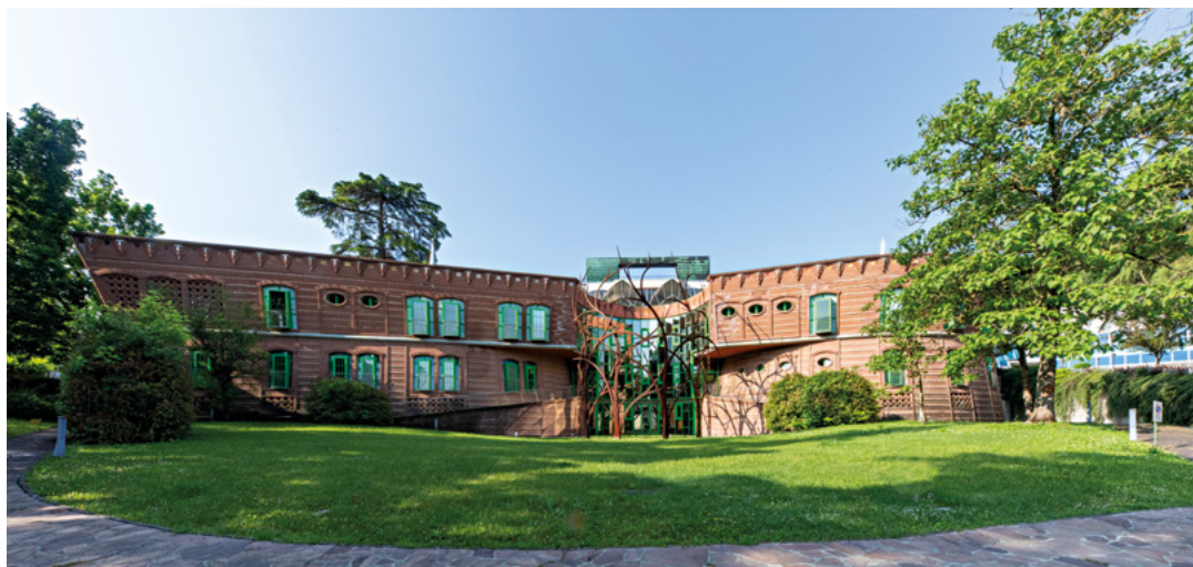
qui e nelle pagine seguenti 1-8. Marco Dezzi Bardeschi, Ampliamento delle Terme Respighi a Tabiano (Salsomaggiore), 1998. Foto di Giuseppe Gradella
