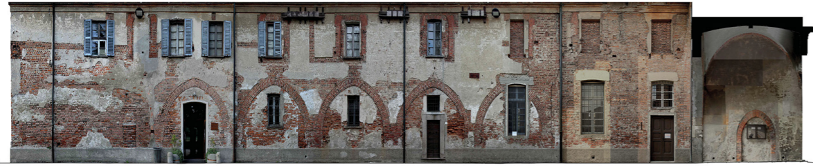
Fig 10 - Il fotopiano (2019) del prospetto nord-est della Foresteria nel quale sono visibili gli arconi e le numerose lacune negli intonaci in gran parte dovute al mancato risarcimento dei saggi effettuati negli anni Cinquanta. Dal 2019 ad oggi abbiamo assistito (e documentato) un'ulteriore perdita degli intonaci e dei materiali in opera di tutte le superfici.
