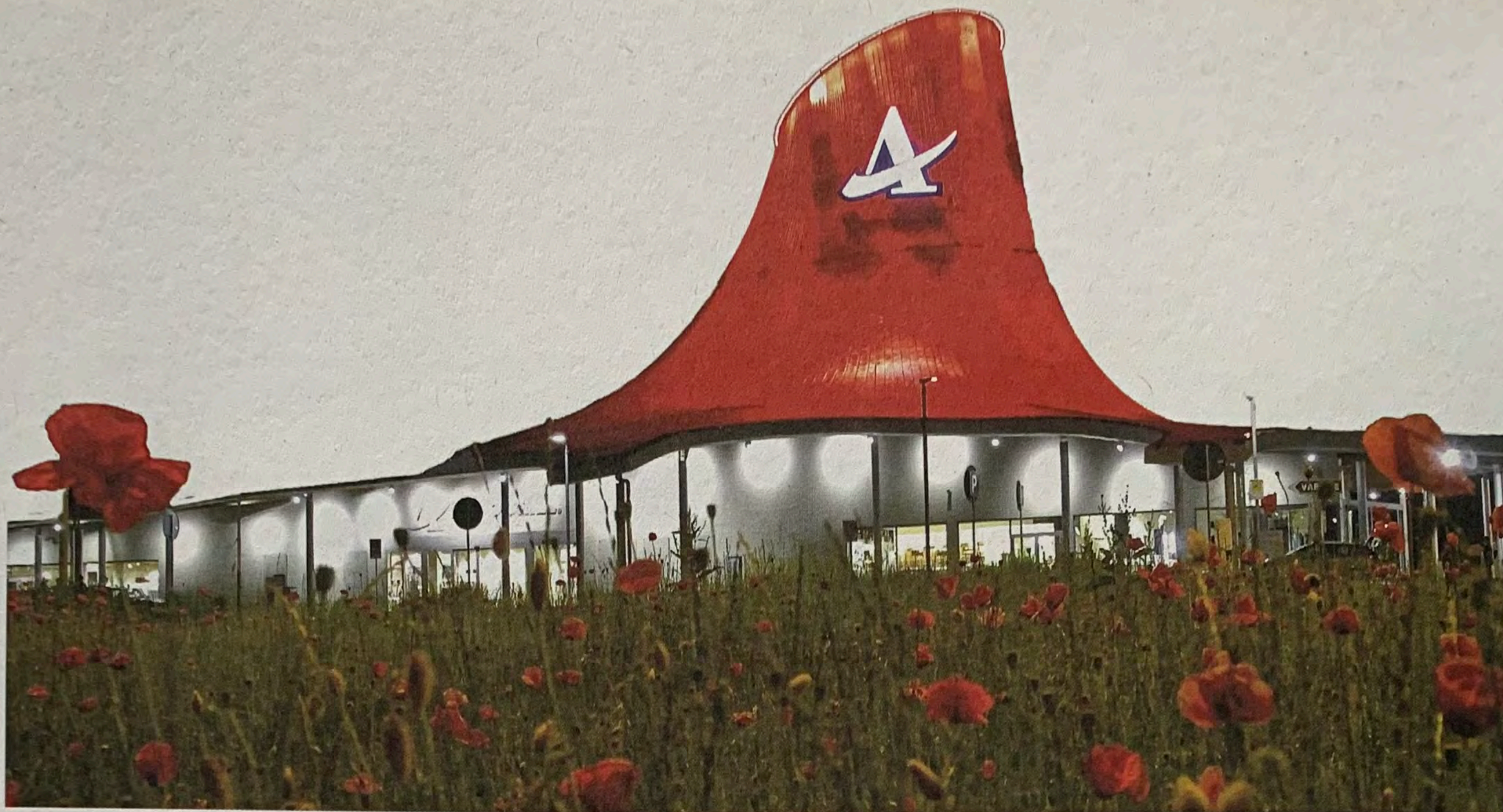
Sopra, veduta dell'Autogrill Villaresi Est con la caratteristica copertura a cono, denominata "il vulcano". Progetto TotalTool, Milano 2014. Nella pagina a fianco, prototipo di Smart garden. Giardino con arredi a secco, modulare che integra vegetazione e impiantistica. Progettato per essere accessibile a diverse categorie di utenti, compresi quelli con disabilità fisiche o sensoriali.
