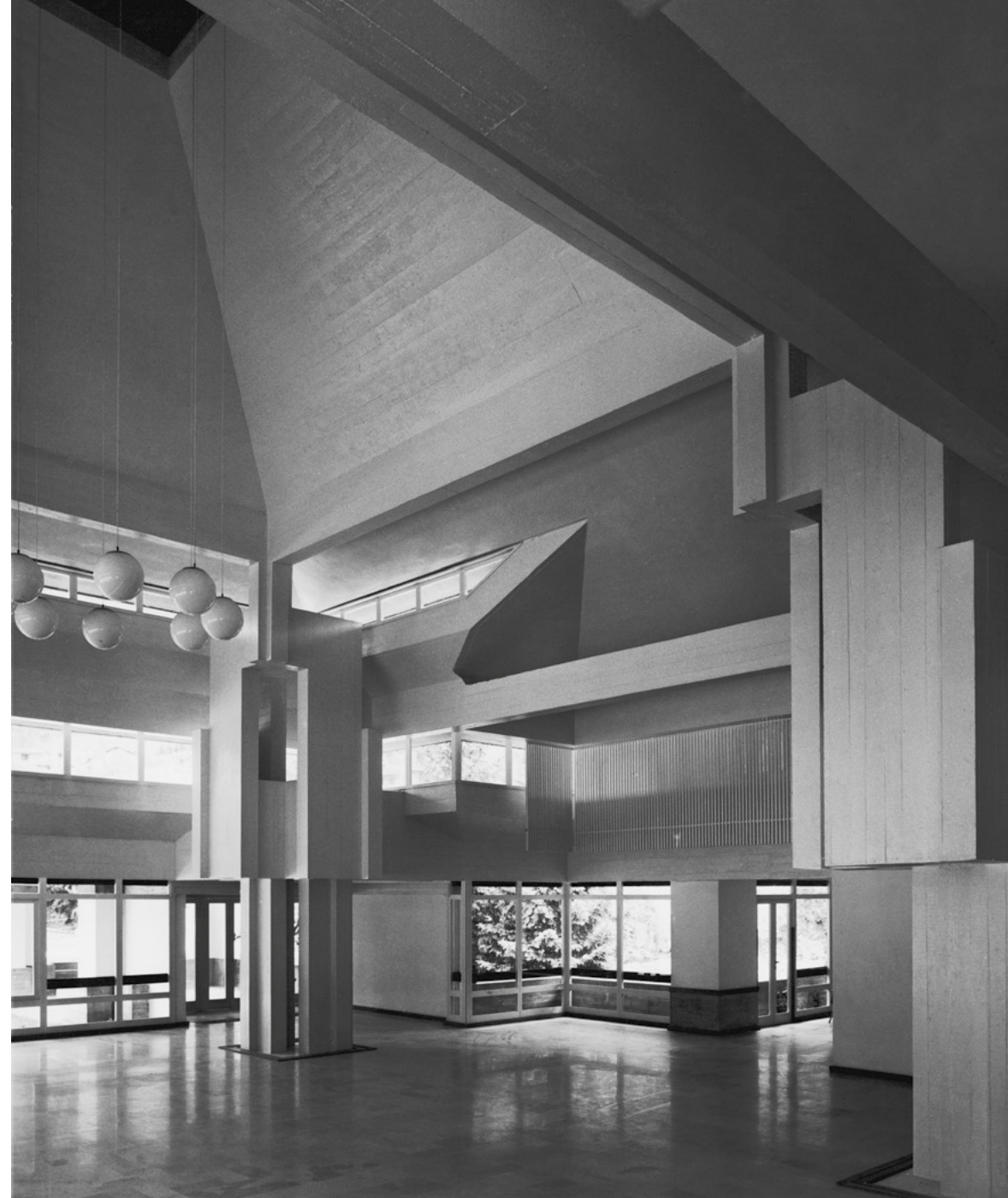
9. Gino Valle, Stabilimento Fonte Pudia ad Arta Terme, particolare. Foto Fulvio Roiter
