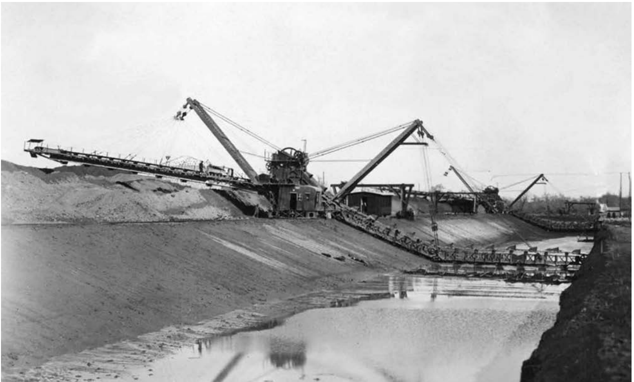
Fig. 2 Escavatori sul Canale delle Acque Alte a Casale Perazzotti presso Latina, 1929 (da: Zucaro 2012).
