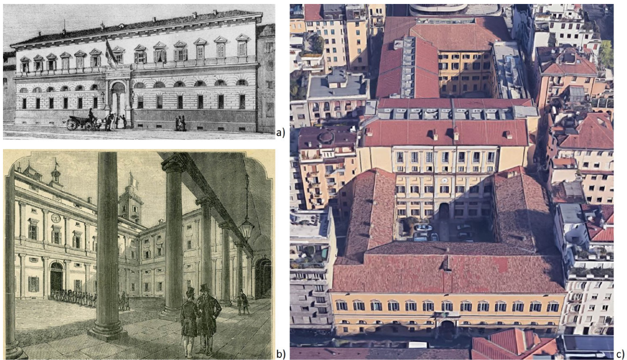
Fig. 2. Milano, il Collegio dei Nobili, ora sede della Questura di Milano. 1) Stampa ottocentesca del fronte principale lungo via Fatebenefratelli; b) stampa ottocentesca del primo cortile interno progettato dall'architetto G. Voghera (da CUZZONI 2016, p. 58); c) una vista aerea del complesso con il sopralzo realizzato su un lato del cortile interno (Google Earth 2021).
