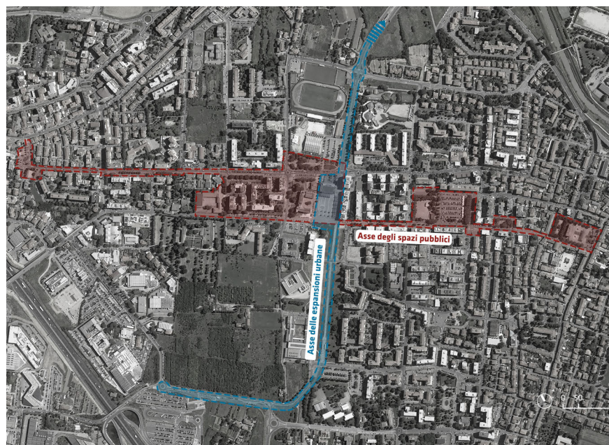
Fig. 7 - I due assi principali che strutturano Scandicci lungo cui si collocano gli spazi pubblici esistenti e le previsioni di trasformazione / The two main structural axis of Scandicci where most public spaces and development areas are located (Source: Authors’ elaboration).
