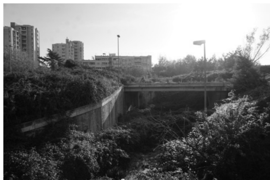
Un campionario di interventi incompleti, irrisolti, inadeguati | Foto del gruppo di lavoro P.R.U. Ponticelli-Ambito 18.
