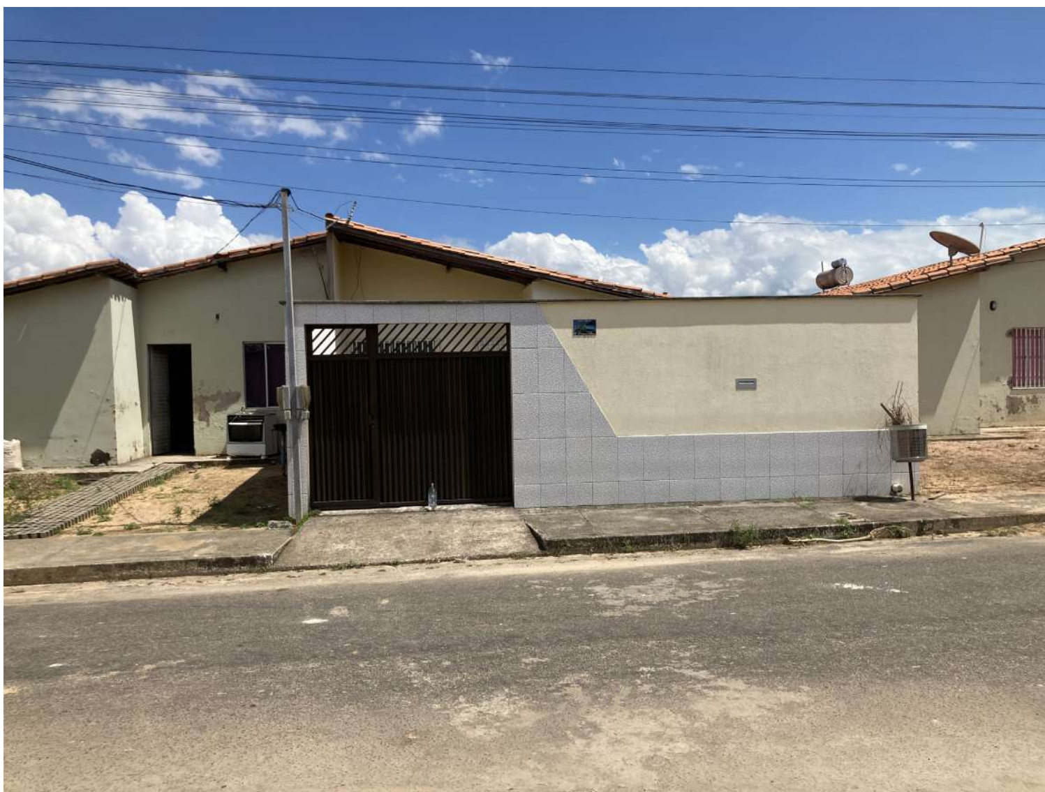
1b. Casa conjugada de um andar isolada em um terreno com uma unidade residencial alterada | Two Family detached house with a residential unit modified | Casa bifamiliare isolata su lotto con una unità edilizia modificata | photo: M. Mareggi
