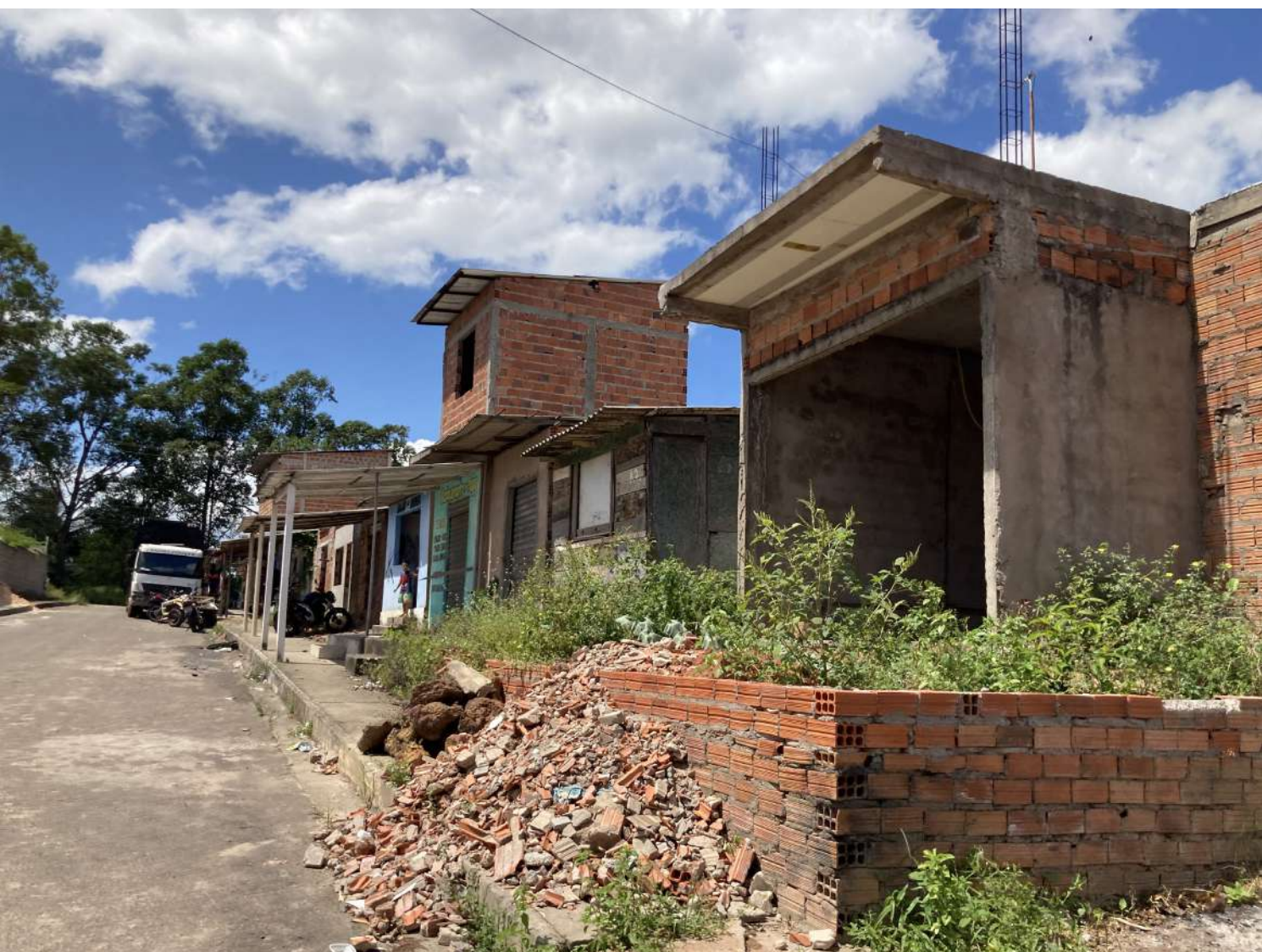
3a. Casas informais de tijolos ao longo da rua que delimita o conjunto habitacional planejado | Informal brick houses along the street bordering the planned neighbourhood | Case informali in mattoni lungo la strada di confine del quartiere pianificato | photo: M. Mareggi
