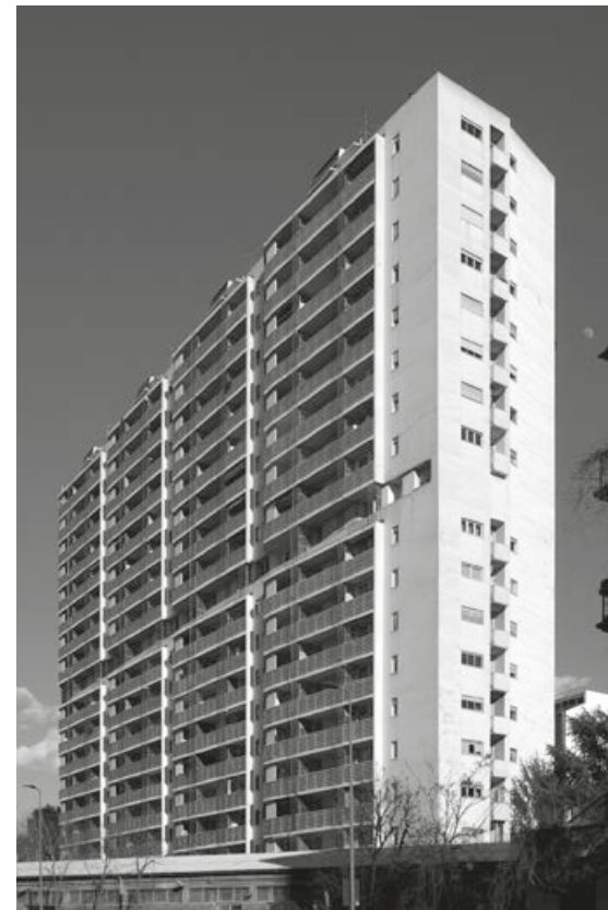
Fig.8 - Il fronte verso l'esterno della città, con i ballatoi dei servizi (fotografia di Stefano Topuntoli)
