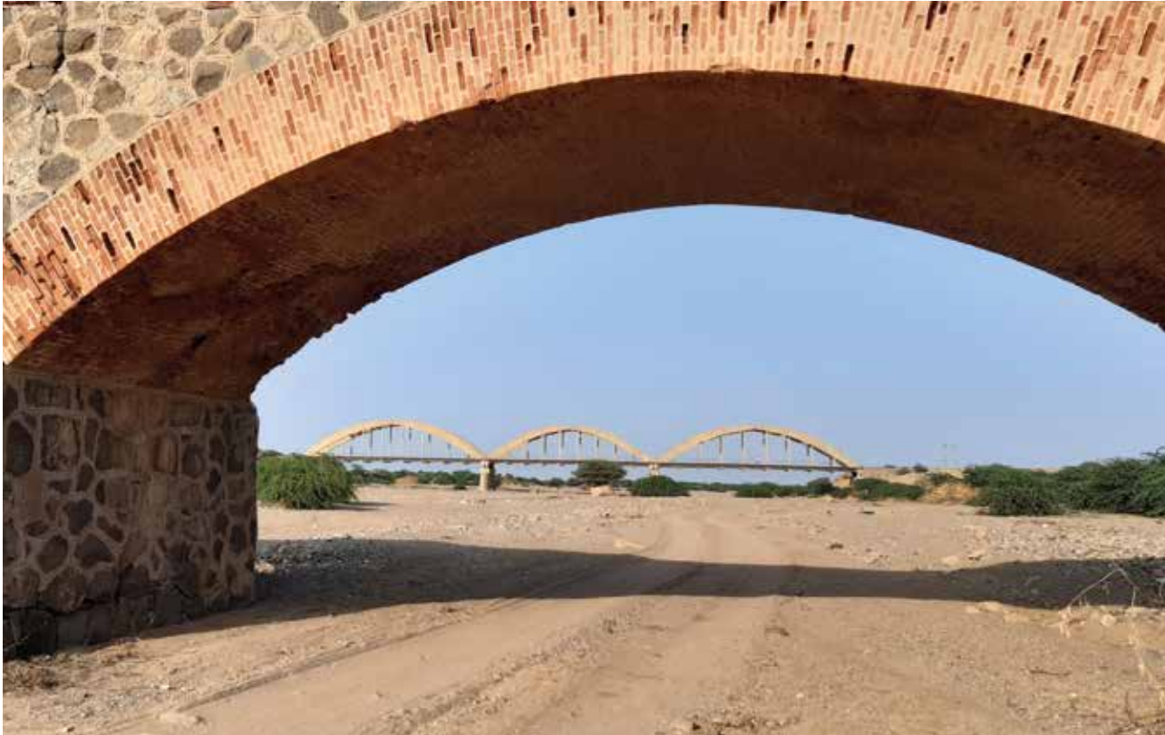
Guido Sassi, Ponte ad arco a via inferiore in cemento armato, 1935, Moncullio, courtesy Susanna Bortolotto, Nelly Cattaneo.
