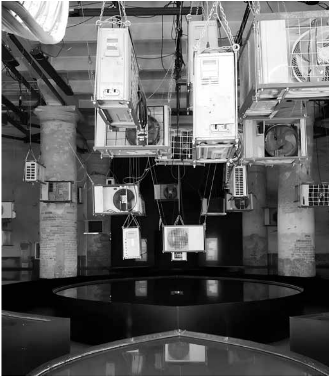
Fig. 3: l'ingresso alle Corderie è introdotto dalle installazioni di Transsolar, Terms and Conditions , e Fondazione Pistoletto Cittadellarte, The Third Paradise Perspective . Raccogliendo in uno spazio interno le unità esterne dei condizionatori e l'aria calda prodotta, l'intento dei curatori è provocare, attraverso il disagio termico, una maggiore consapevolezza sui reali costi del comfort negli ambienti climatizzati. © G. Croce.
