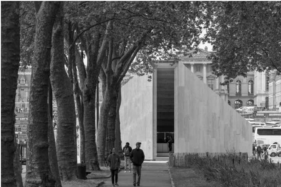
Il padiglione La Petite Agora de la Métropole du Grand Paris di Jean-Christophe Quinton, nato per ospitare un ciclo di incontri, è realizzato secondo una tecnica di lamellé-cloué, allo scopo di ridurre l'impronta di carbonio e di immaginare una possibile ricollocazione futura. BAP!, Versailles, 2025. © Région Ile-de-France Communication.
