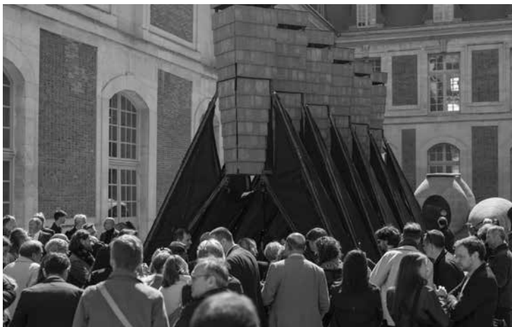
L’installazione Atrapaviento , del collettivo C733, è composta da sei camini solari in grado di rinfrescare lo spazio mediante un sistema passivo di convezione dell’aria. BAP!, Versailles, 2025. © Région Ile-de-France Communication.
