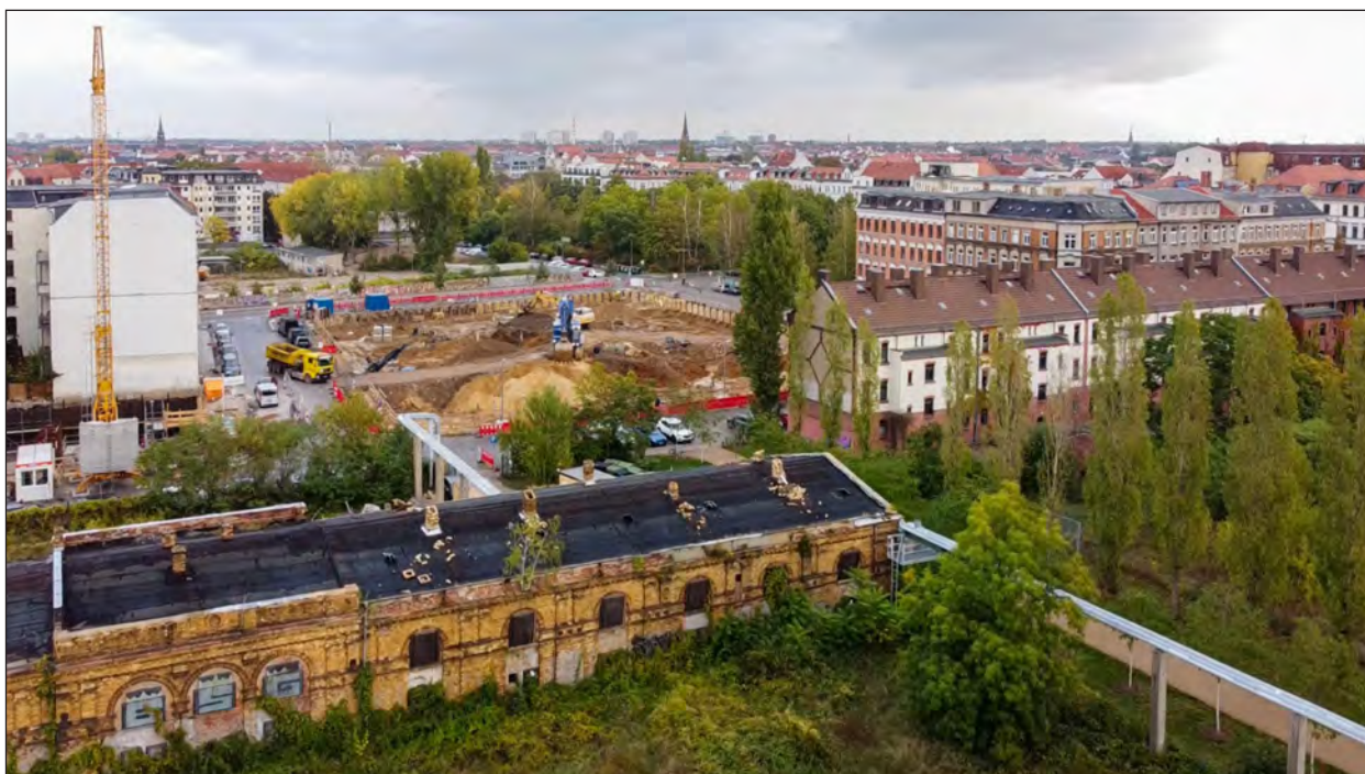
Figure 10. Cantiere situato nei pressi del Lene-Voigt-Park e del quartiere Reudnitz-Thonberg, destinato alla realizzazione di un complesso residenziale. Ottobre 2021. Fonte: autore .
