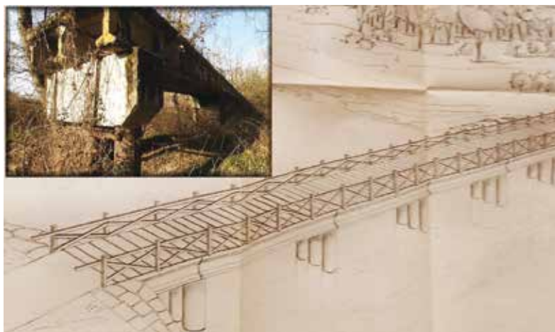
1. Resti del ponte sul Ticino, costruito su progetto dei primi anni Sessanta, presso Isola Ochetta in zona Bucella a Vigevano (PV): la rampa e la strada di adduzione furono distrutte da un evento di piena e il fiume cambiò il suo corso a fine anni Settanta
