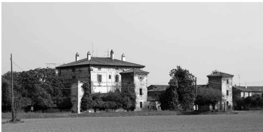
Fig. 1 – Villa Cavallara, presso San Martino in Beliseto, vista dalla strada Quinzanese
