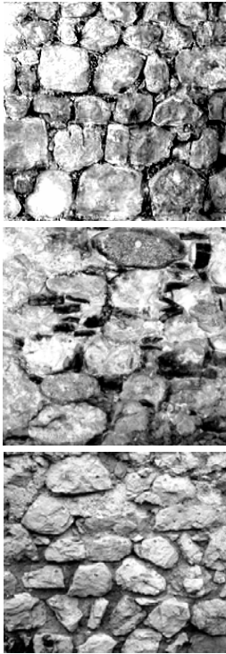
Fig. 12. Tessiture murarie rispettivamente delle murature esterne, di partizione interna e del Mastio
