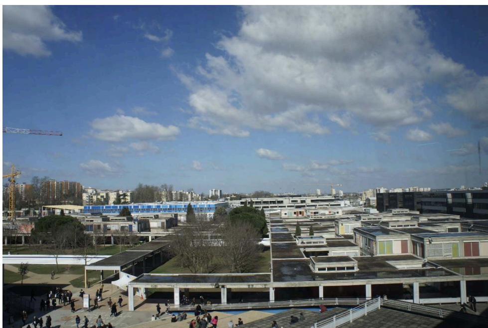
Figure 10. Vue d'en haut de l'université Toulouse-Le Mirail avant la reconstruction, 2015
