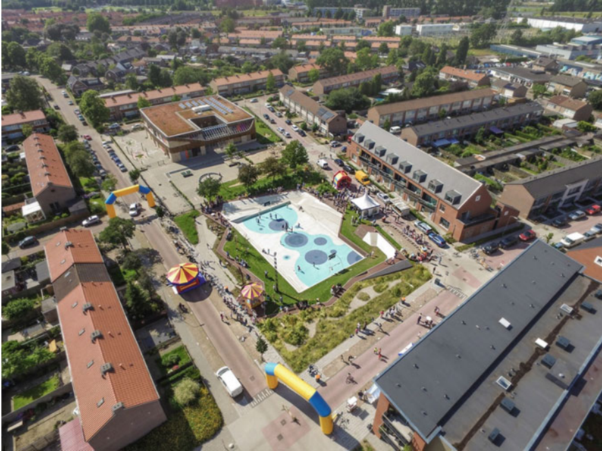
Fig. 59.4 Watersquare, Tiel, 2014–2016, De Urbanisten, Ph. De Urbanisten
