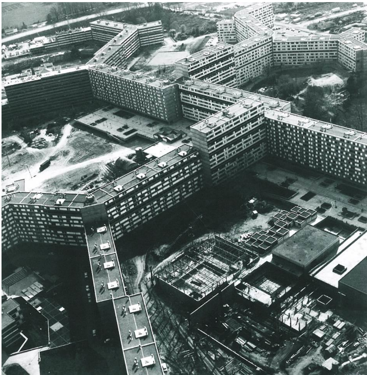
Figura 15_ I grandi tripodi e i blocchi dei servizi in costruzione
