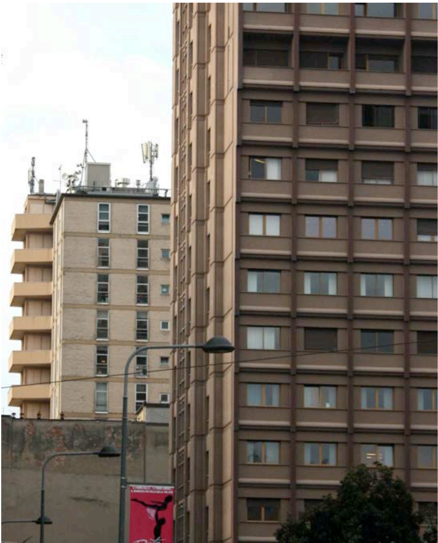
Giovanni e Lorenzo Muzio, Torre Turati 2, particolare della cortina a elementi prefabbricati (sullo sfondo la torre della Permanente)
