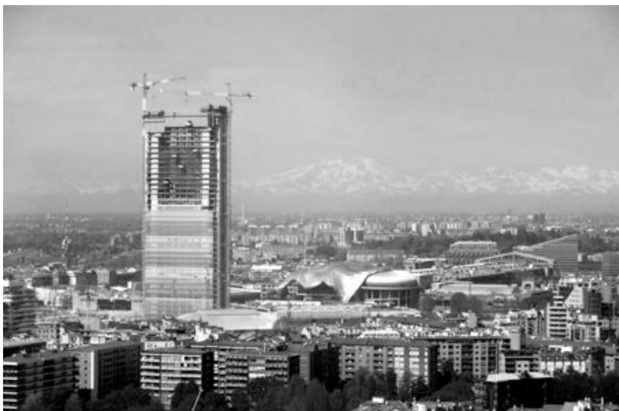
Arata Isozaki, Andrea Maffei, Torre Isozaki in costruzione
