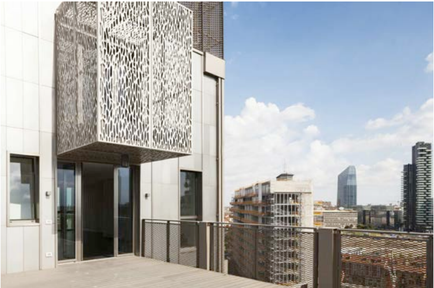
Vudaferi Saverino Partners, V33, vista di una delle terrazze degli ultimi piani della torre, foto Filippo Romano
