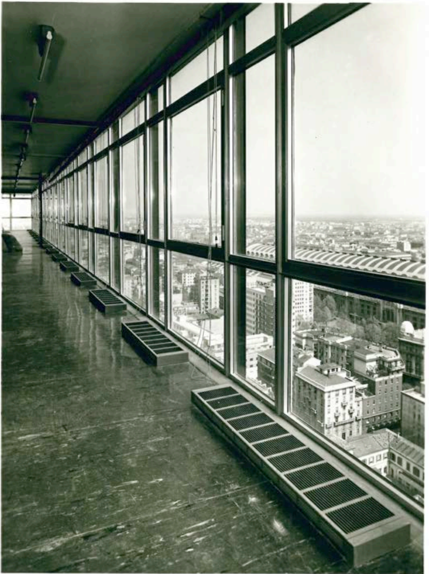
Melchiorre Bega, Torre Galfa, particolare della cortina, Archivio Bega
