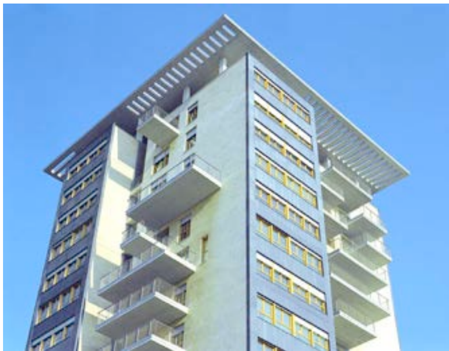
Massimiliano e Doriana Fuksas, Torri Area OM, dettaglio, foto Carlo Valsecchi per Studio Fukas
