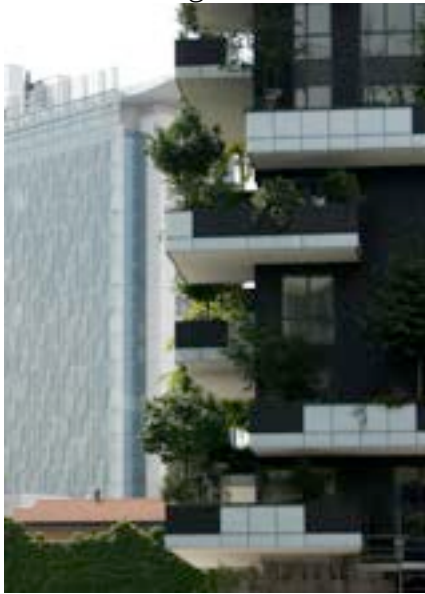
Stefano Boeri Architetti, Bosco verticale, dettaglio del rivestimento a lastre bicolore
