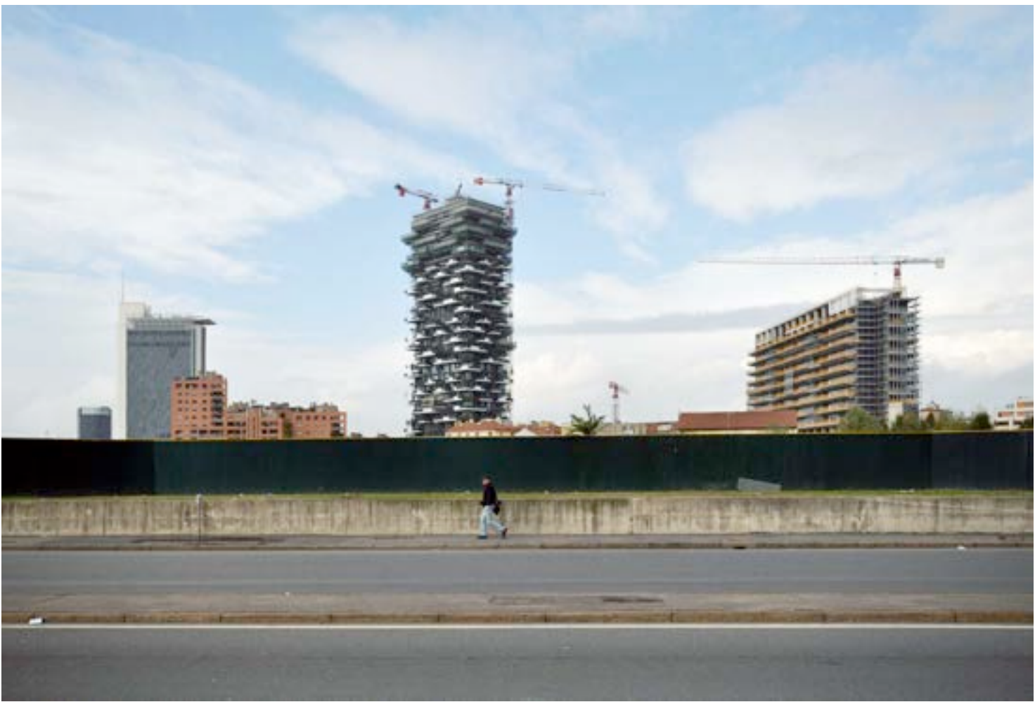
Il Bosco Verticale in costruzione, foto Marcello Modica
