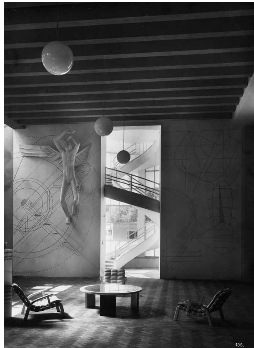
Scala elicoidale e parete di fondo della galleria in una foto del 1933, durante la Mostra internazionale dei trasporti (V Triennale 1933). Foto di Stabilimento fotografico, courtesy © Triennale Milano - Archivi.
