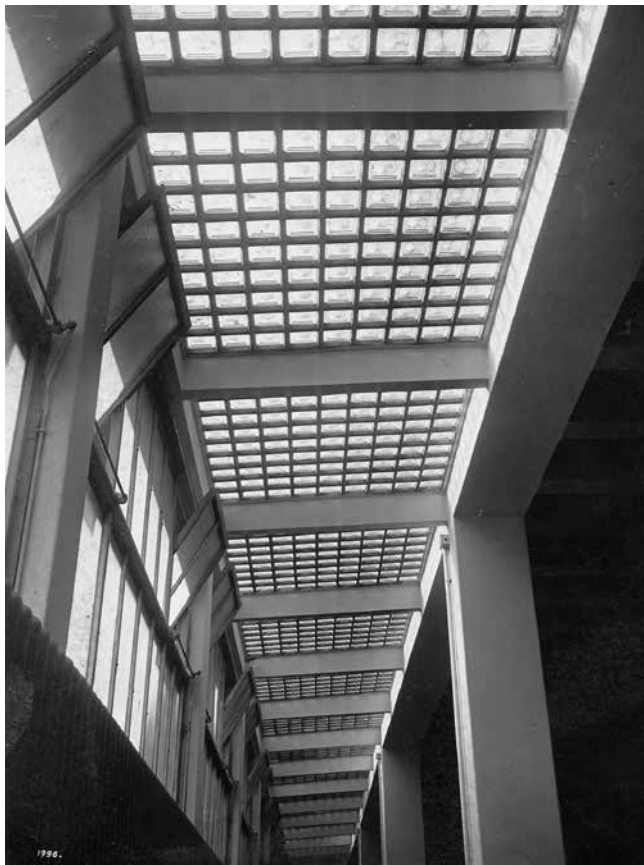
Sistema di illuminazione naturale della galleria: finestratura verticale apribile e lucernario in formelle di vetro-cemento traslucide, in una foto del 1933. Il sistema è stato oggetto di restauro durante il progetto di Cuore, mantenendo i caratteri materici e dimensionali originari. Foto di Stabilimento fotografico, courtesy © Triennale Milano - Archivi.
