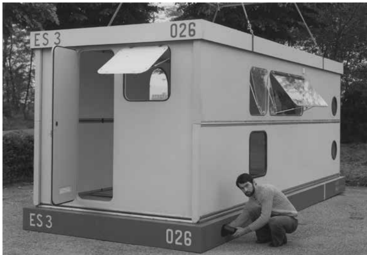
Fig. 2: Fasi di montaggio di unità per emergenza di Montedil, in Abitazioni per l'emergenza , Parco Sempione, fascia antistante il Palazzo dell'Arte. Courtesy © Triennale Milano - Archivi.
