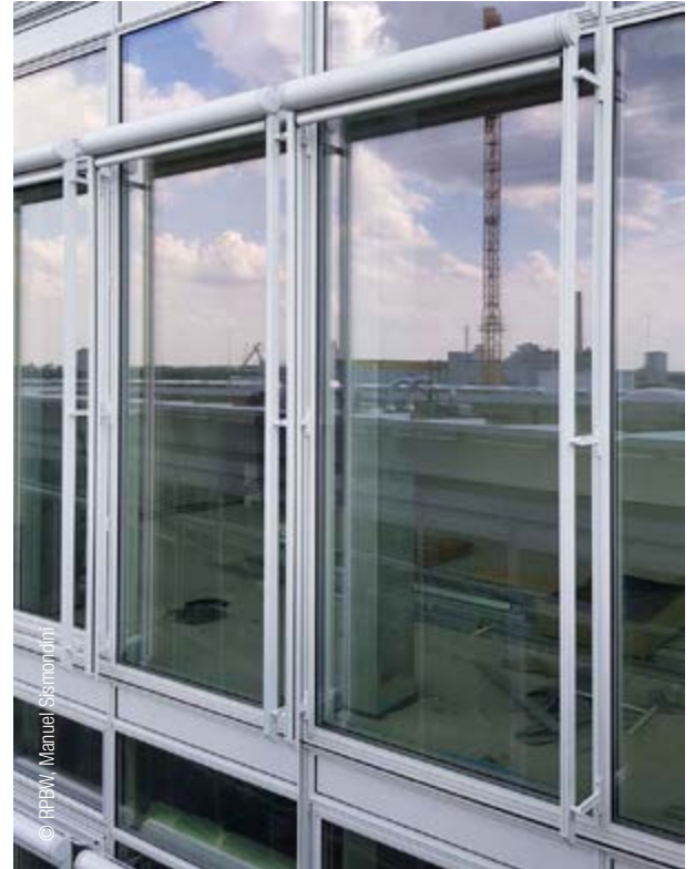
Intelaiatura dei moduli a cellula, provvisti della sottostruttura esterna a supporto degli avvolgibili
