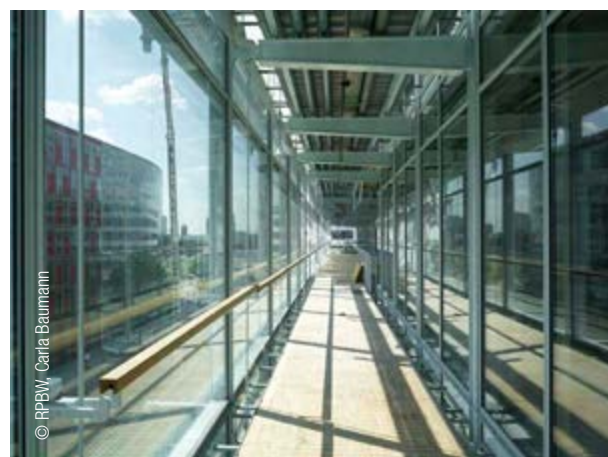
Visualizzazione dell'intercapedine compresa nella passerella tra le due superfici di facciata
