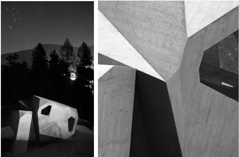
Fig. 06-07. Mini centrale Idroelettrica di Cillà (TN) (© D. Marchiori, 2017, © S. Guetti, 2017)
