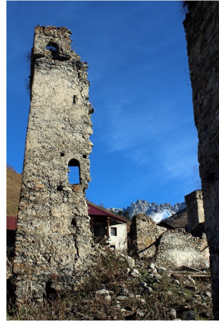
Fig. 3 Upper Svaneti, Georgia. Le condizioni di conservazione di una torre nel villaggio di Adishi (foto S. Pistidda, 2018).
