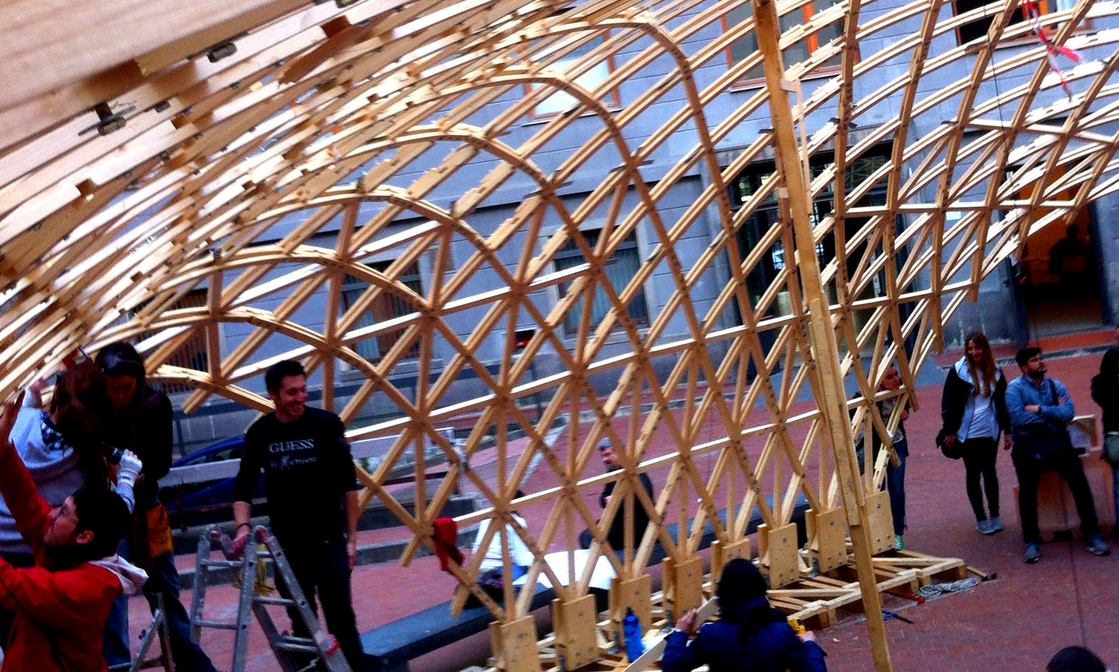
Fig. 1 Toledo Gridshell in costruzione (Foto Daniele Lancia)
