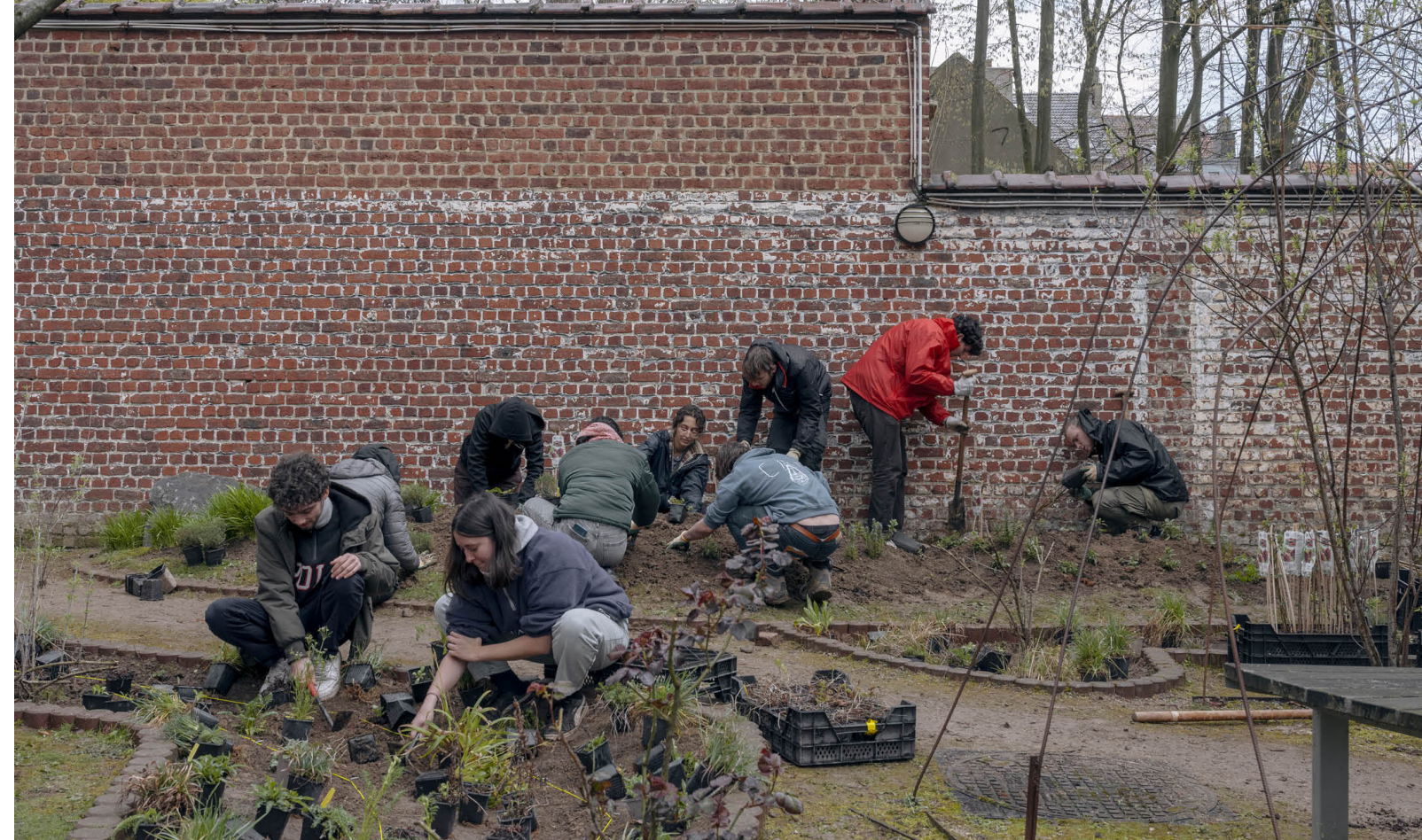
Figura 3: la piantumazione del bacino d'infiltrazione nel giardino collettivo umido di Strauwen durante il workshop di autocostruzione.
