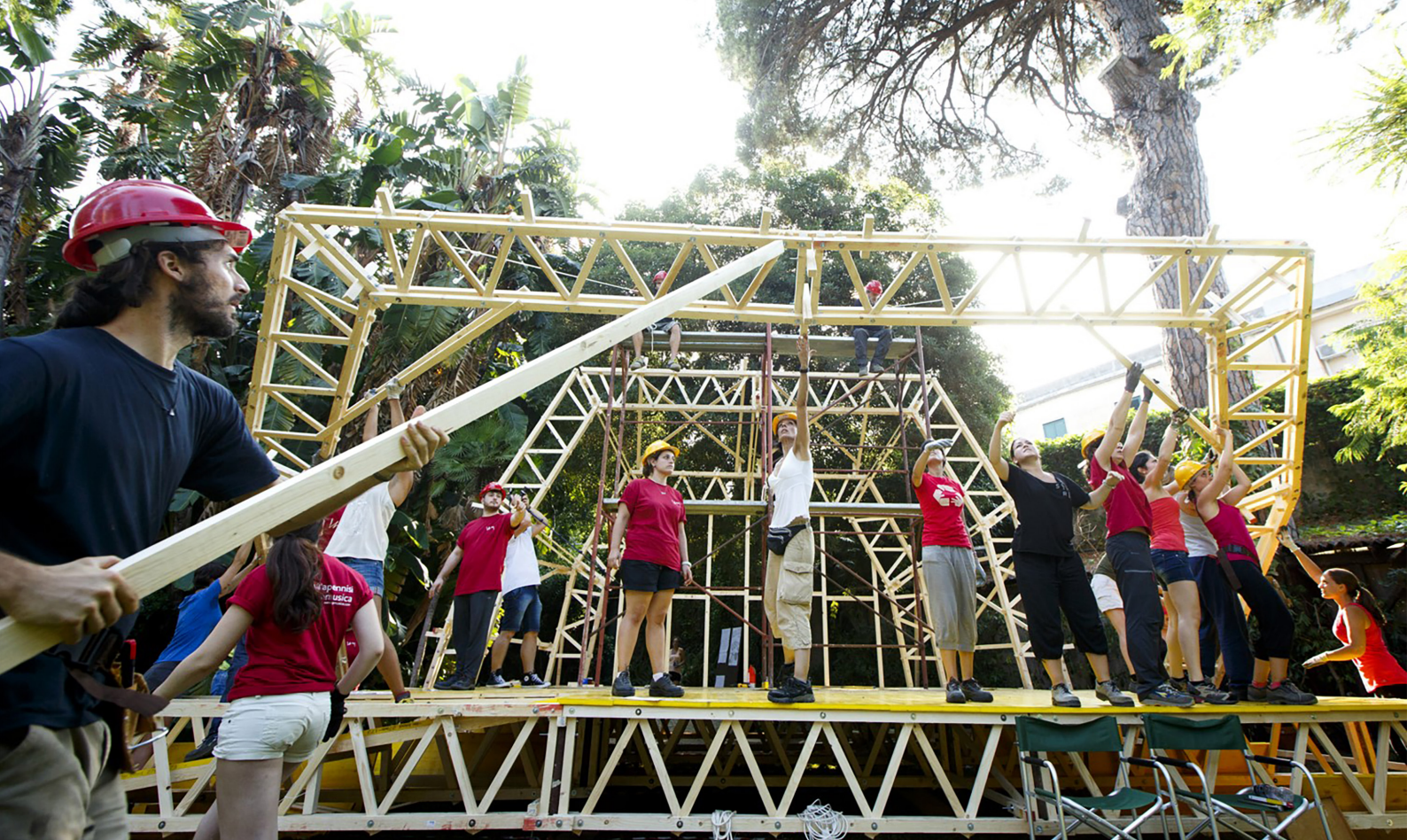
Fig. 4 - ReS 11.0 in costruzione, foto Flavio Ianniello
