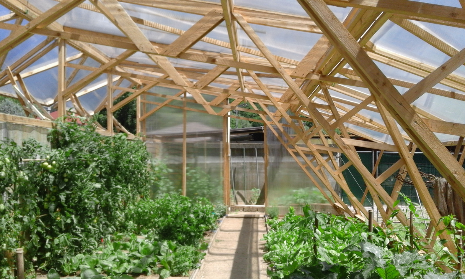
Fig. 1. Vista dei portali asimmetrici reticolari realizzati nella prima serra a Fagnano Olona. (Annalisa Banfi, Eva Cividini, Giovanni Di Fiore, Giacomo Lunghi, Federico Mira, Federico Monti. 2016-17).
