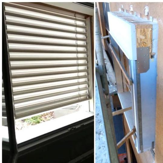
Figura 42: Protezioni solari esterne e eliminazione ponti termici all'imbotte e alla soglia delle finestre. Fonte: Progetto EU-GUGLE, Ristrutturazione edifici ER, Chiaravalle, Milano.
