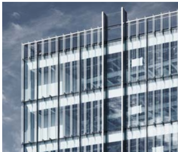
Sistema di facciata marcato dalle trame modulari, dalle fasce in vetro serigrafato e dalle lesenature verticali in alluminio
