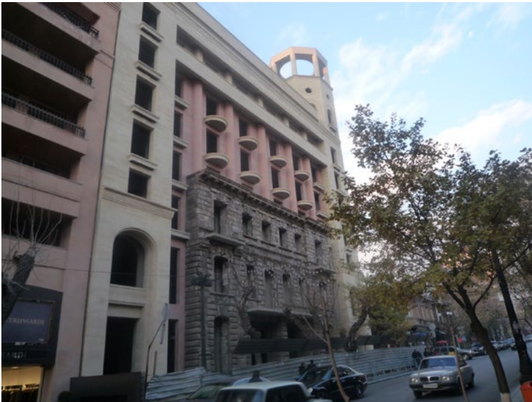
Figura 20. Yerevan (Armenia). Una facciata usata a “decorazione” di un moderno condominio (foto R. Simonelli, 2014).
