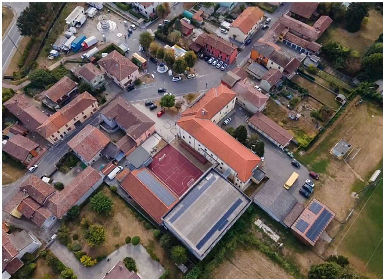
Fig. 3. Lodi, comune di Turano Lodigiano. Pannelli fotovoltaici ubicati sul tetto degli spogliatoi della palestra e del campo sportivo comunale a servizio della CER (< https://www.thegoodintown.it/solisca-la-comunita-energetica-di-turano-lodigiano/ > [10/10/2023]).
