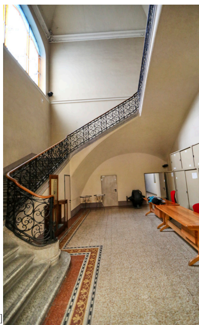
Fig. 4. Due recenti immagini dello scalone principale, realizzato durante gli Anni Venti con struttura in cemento demolendo una partizione orizzontale in volta a fasce [fotografie degli autori].
