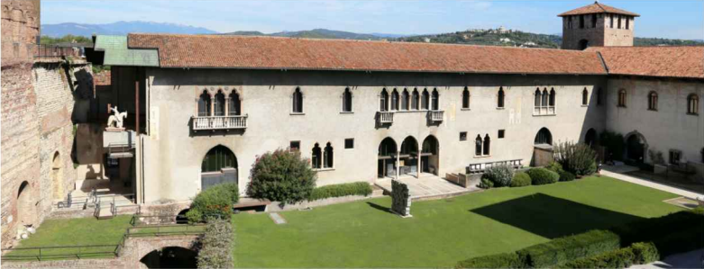
Imagen 15. Verona. Carlo Scarpa, Museo de Castelvecchio, 1957-1975. Inserciones, Sustituciones, Trasformaciones, Laceraciones, Permanencias
