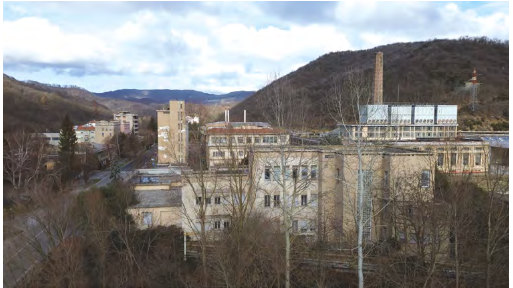
05. View of the current condition of the former film factory in Ferrania, Cairo Montenotte, Bormida Valley | Veduta dello stato attuale dell'ex stabilimento di materiale fotosensibile di Ferrania, Cairo Montenotte, Valle Bormida. Land-In-Pro , 2024
