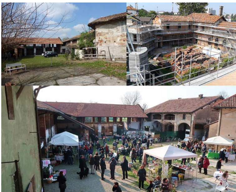
Fig. 4. Immagini della corte della cascina prima, durante e al termine del cantiere di conservazione (foto: C. Campanella 2012, Donatello SpA 2015, P. Zandrini 2016).
