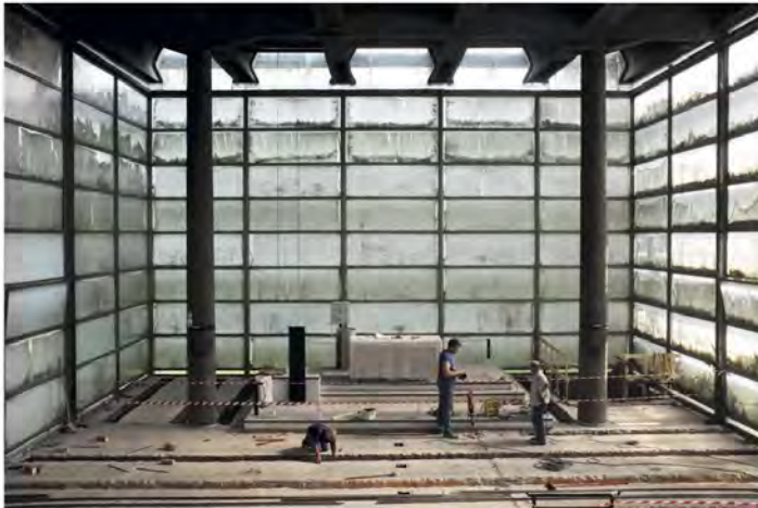
4 Angelo Mangiarotti, Bruno Morassutti and Aldo Favini: Baranzate, Nostra Signora della Misericordia , 1956–1958, internal view, works opening, 2013
