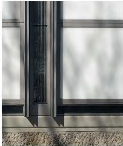
13 Angelo Mangiarotti, Bruno Morassutti and Aldo Favini: Baranzate, Nostra Signora della Misericordia , 1956–1958, restoration project SBG architetti, 2014, final cladding, 2015
