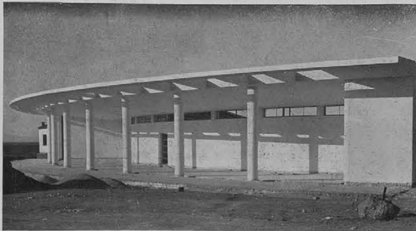
FAÇADE SUD, CAISSONS DE L'AUVENT ENLEVÉS
