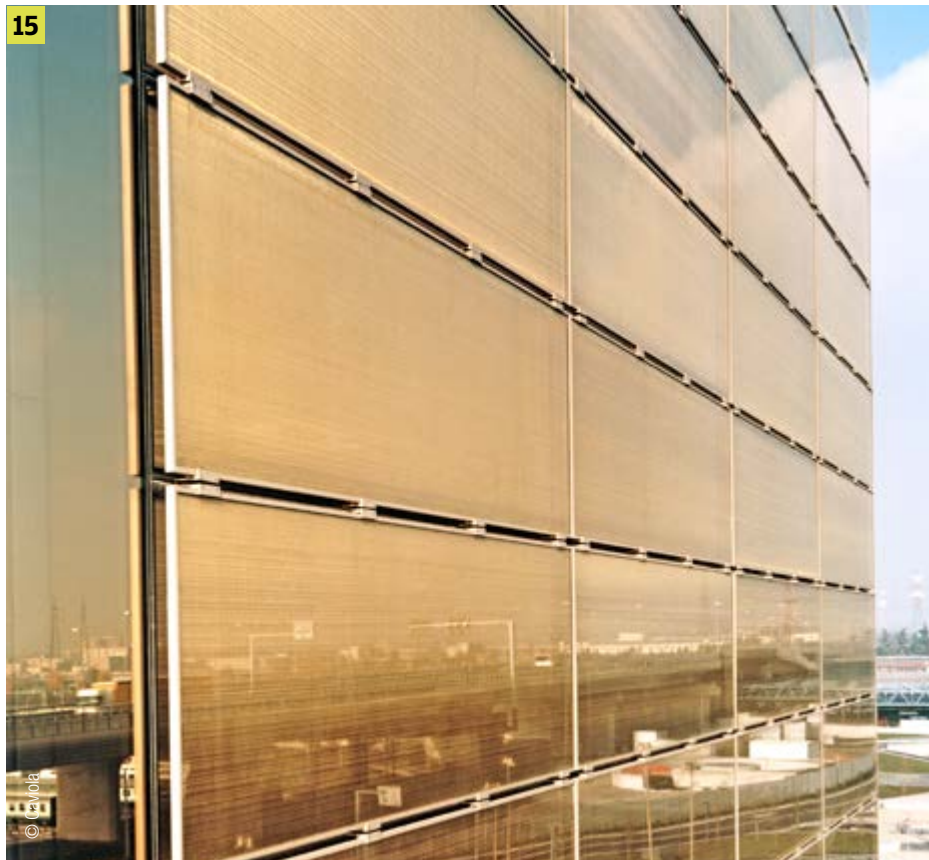
15 Paradigma dell'“integrazione” e tipo di “facciata polifunzionale”: involucro quale apparato di correlazione tra molteplici dispositivi e “sotto-componenti”, quali le sezioni di aerazione, le schermature solari e le aperture (per finestre a sporgere e con movimentazione parallela, con azionamento per mezzo di motore elettrico a scomparsa; produzione Reynaers)
