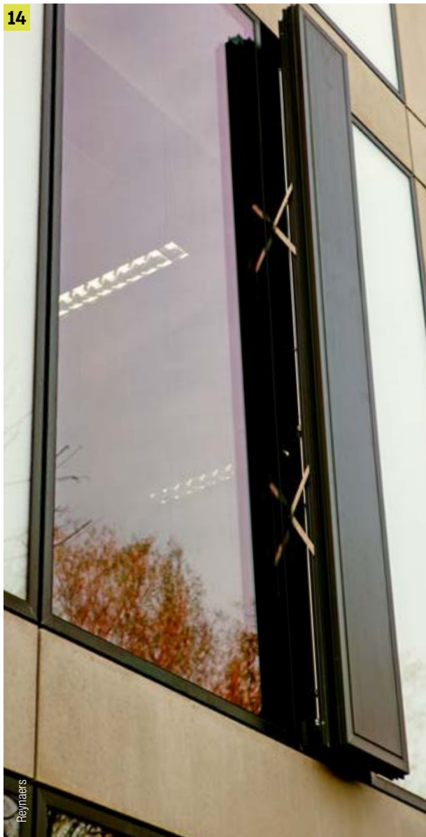
15 Paradigma dell'“integrazione” e tipo di “facciata polifunzionale”: involucro quale apparato di correlazione tra molteplici dispositivi e “sotto-componenti”, quali le sezioni di aerazione, le schermature solari e le aperture (per finestre a sporgere e con movimentazione parallela, con azionamento per mezzo di motore elettrico a scomparsa; produzione Reynaers)
