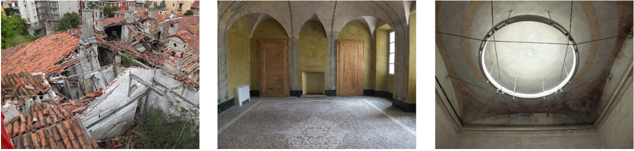
Fig. 3. Villa Simonetta a Verbania. 3a, condizioni della villa ad inizio cantiere (foto P. Bassani 2019); 3b, Sala neogotica a fine lavori con la tecnica dell'arco armato intradossale e il restauro delle superfici; 3c, vista del Lampadario armato (foto P. Bassani 2022).
