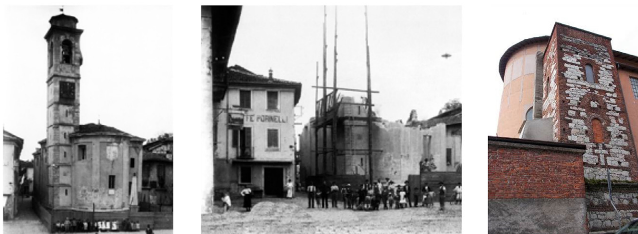
Fig. 2. Sesto Calende (VA), Chiesa di San Bernardino. 2a e 2b, demolizione dell'antica chiesa di San Bernardino del XV secolo nel 1904 (elab. E. Varalli 2001); 2c, campanile incompiuto della nuova chiesa (foto G. Cardani 2018).
