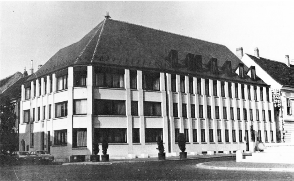
4: Bórbiró, Z. Déák, Street View of House of Diplomats, 1983 [Magyar Építőművészet 1983/1, p. 32].
